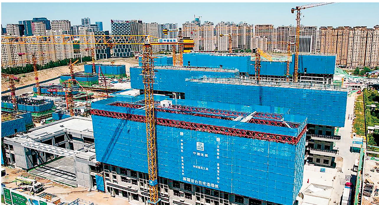
7月21日，新疆乌鲁木齐市水磨沟区一处建筑施工现场，住宅“造楼机”正在进行模块式住宅施工作业。
