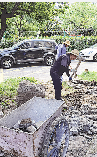
物业工作人员修步道。
