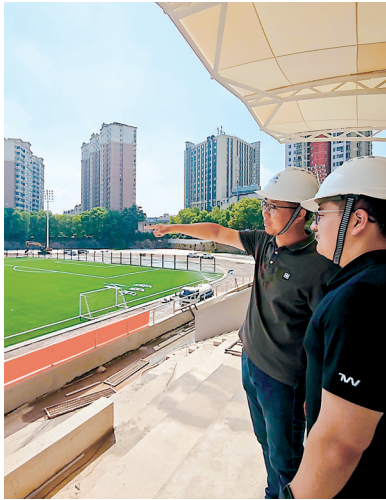
武泰闸体育场建起新足球场和看台。 记者宋磊 摄
