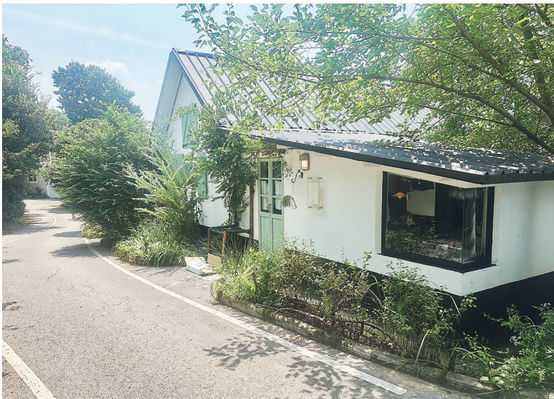
嵩阳森林公园山脚下的法式餐厅，由闲置民房改造。
