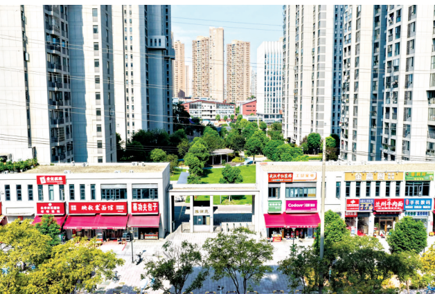
整改后的沿街商铺。
