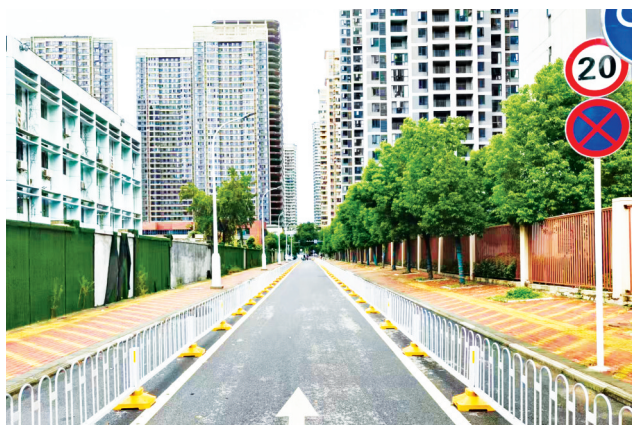
整改后道路平整。
