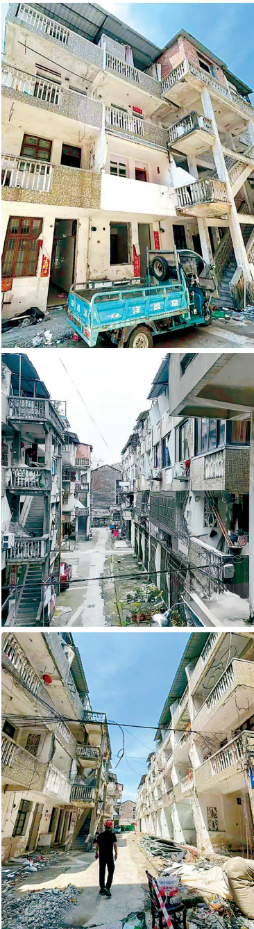
拆除施工中的虹苑小区。
