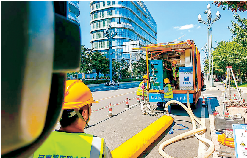
施工人员正在开展地下管网紫外光固化非开挖修复作业。
