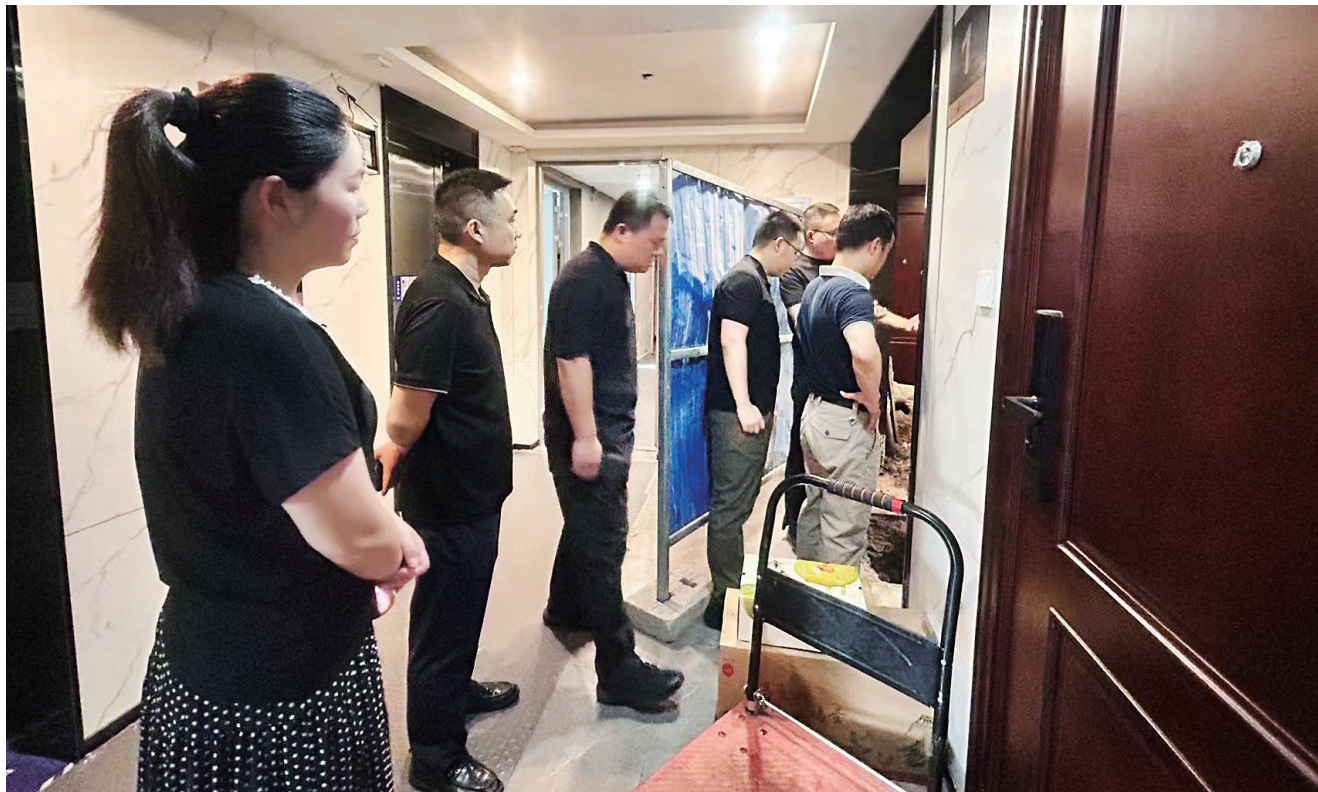
查看现场维修进度。
