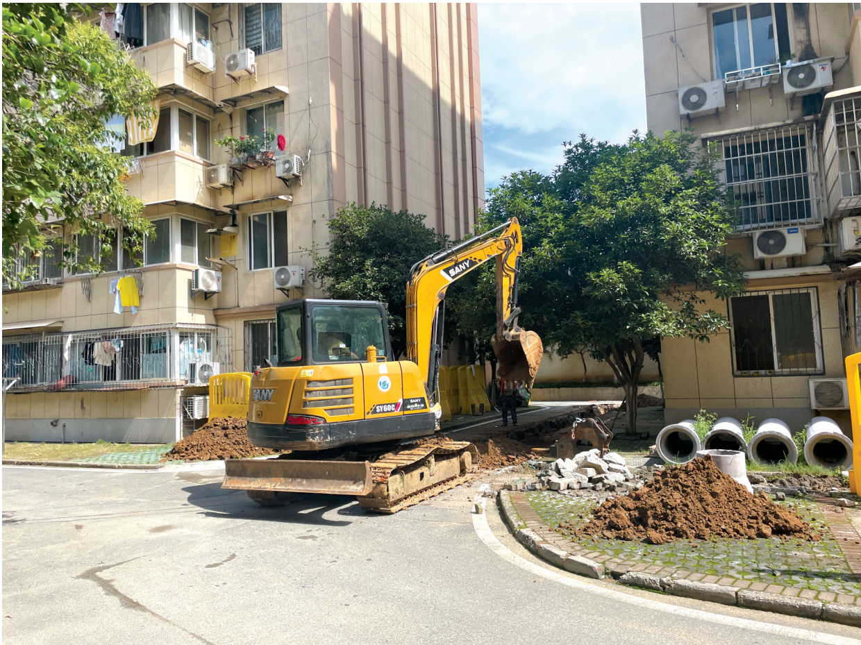
老旧管网改造施工。
