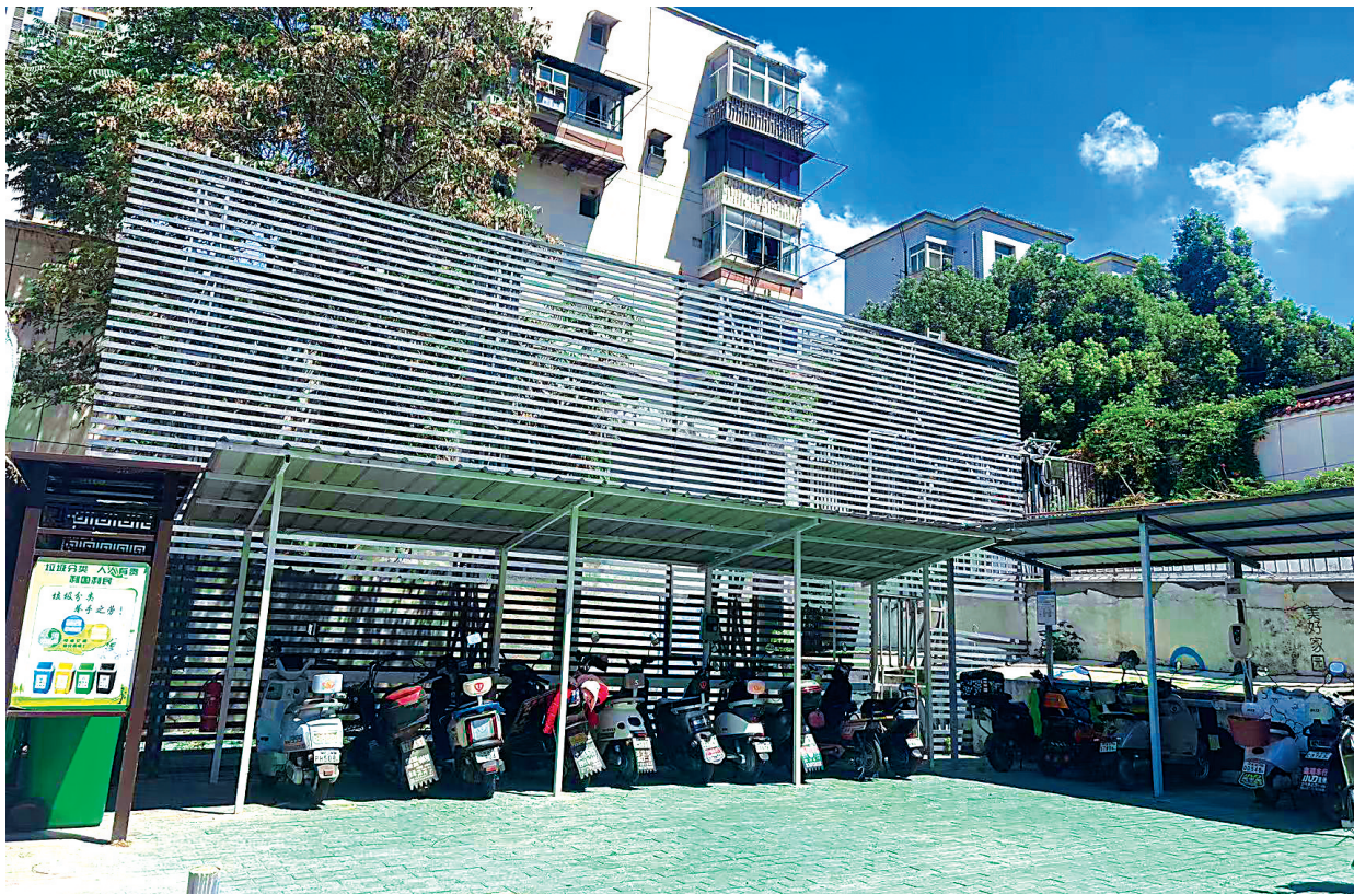
外包宿舍电动车棚修建后。
