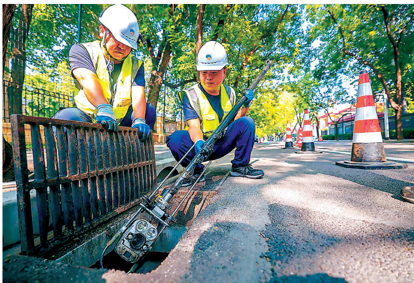
北京市政工人对地下排水管网进行全面“体检”。
