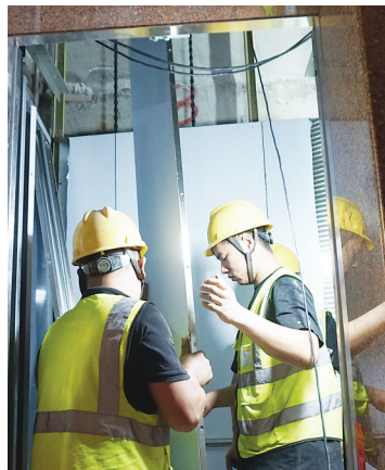
正在施工的电梯。 记者秦璟 摄
