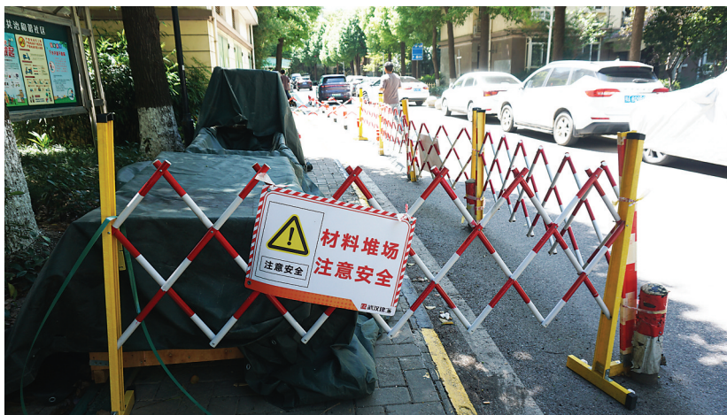
换电梯难免影响业主生活,施工方尽力做到“有温度的施工”。
