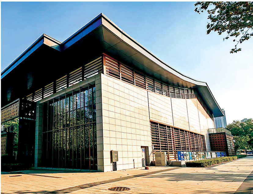
解放公园综合体育馆采用较长悬挑,四角用敦实墙面,使建筑轮廓更易被鸟类识别。
