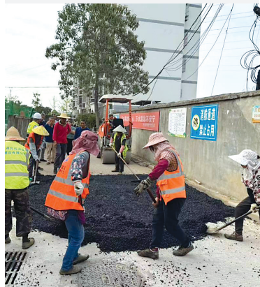
小区道路铺设沥青。
