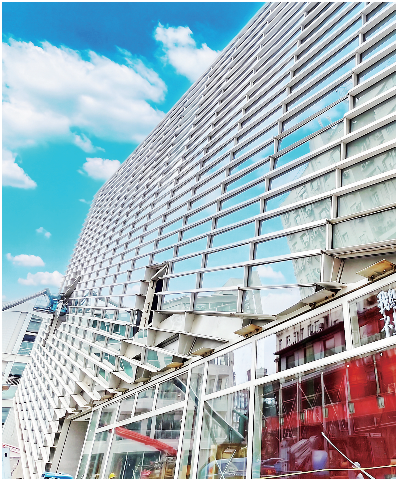
广埠屯·锦鲤项目施工现场。
