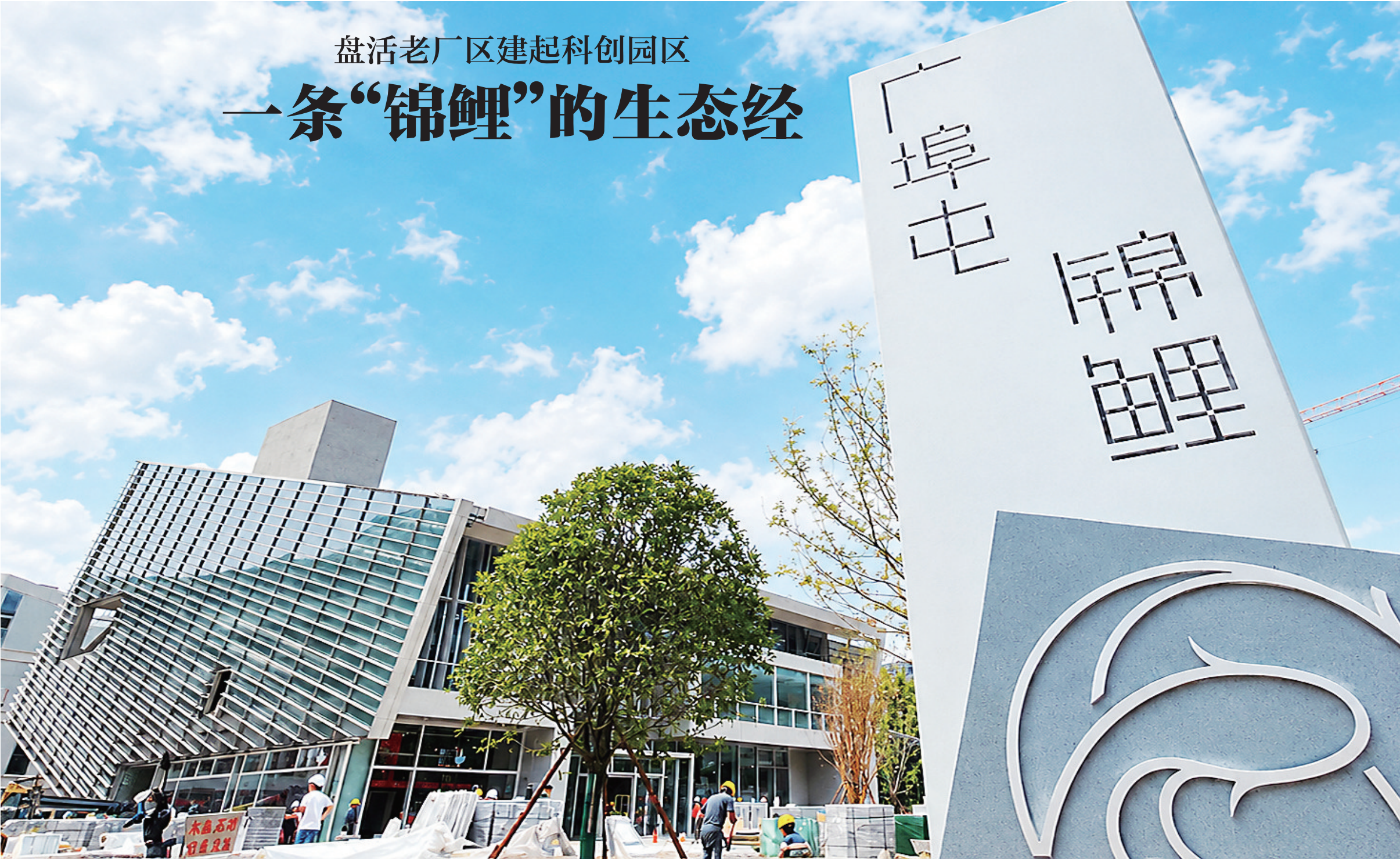
广埠屯·锦鲤项目施工现场。
