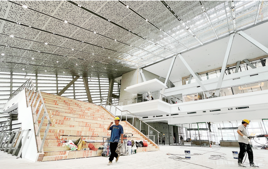
广埠屯·锦鲤项目施工现场。
