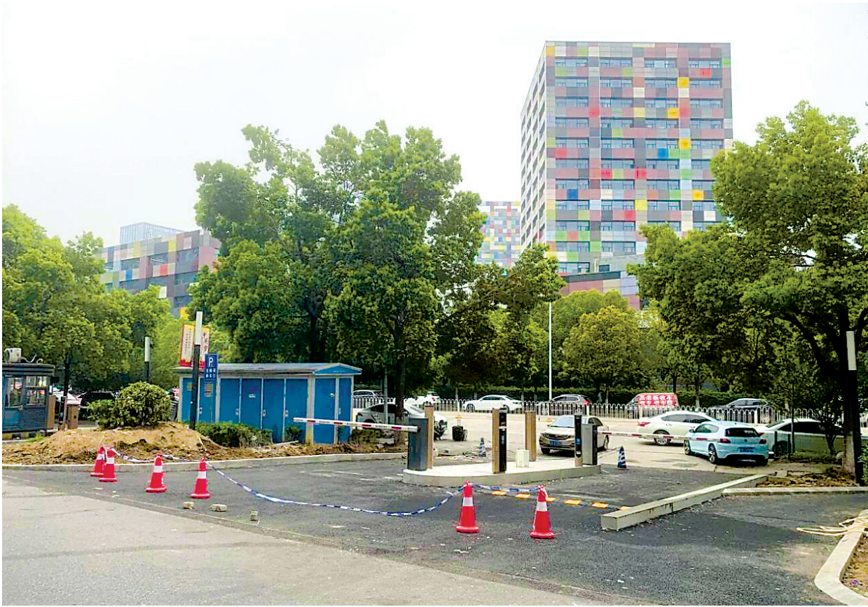
5号岗亭新增了双向道口。
