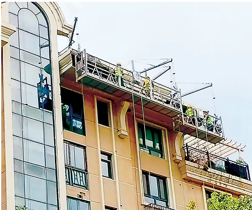
改造项目已于今年7月开工，目前3栋楼率先完成隐患部位集中拆除。
