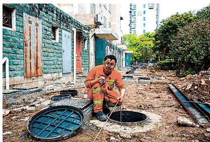
宁波市北仑区新碶街道太阳园小区进行管道改造。
