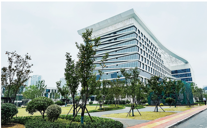
武汉轨道交通国博线网控制中心。
