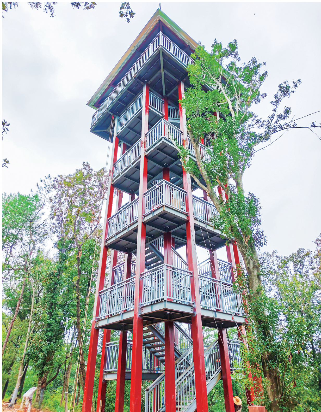
团山新修的防火哨塔。
