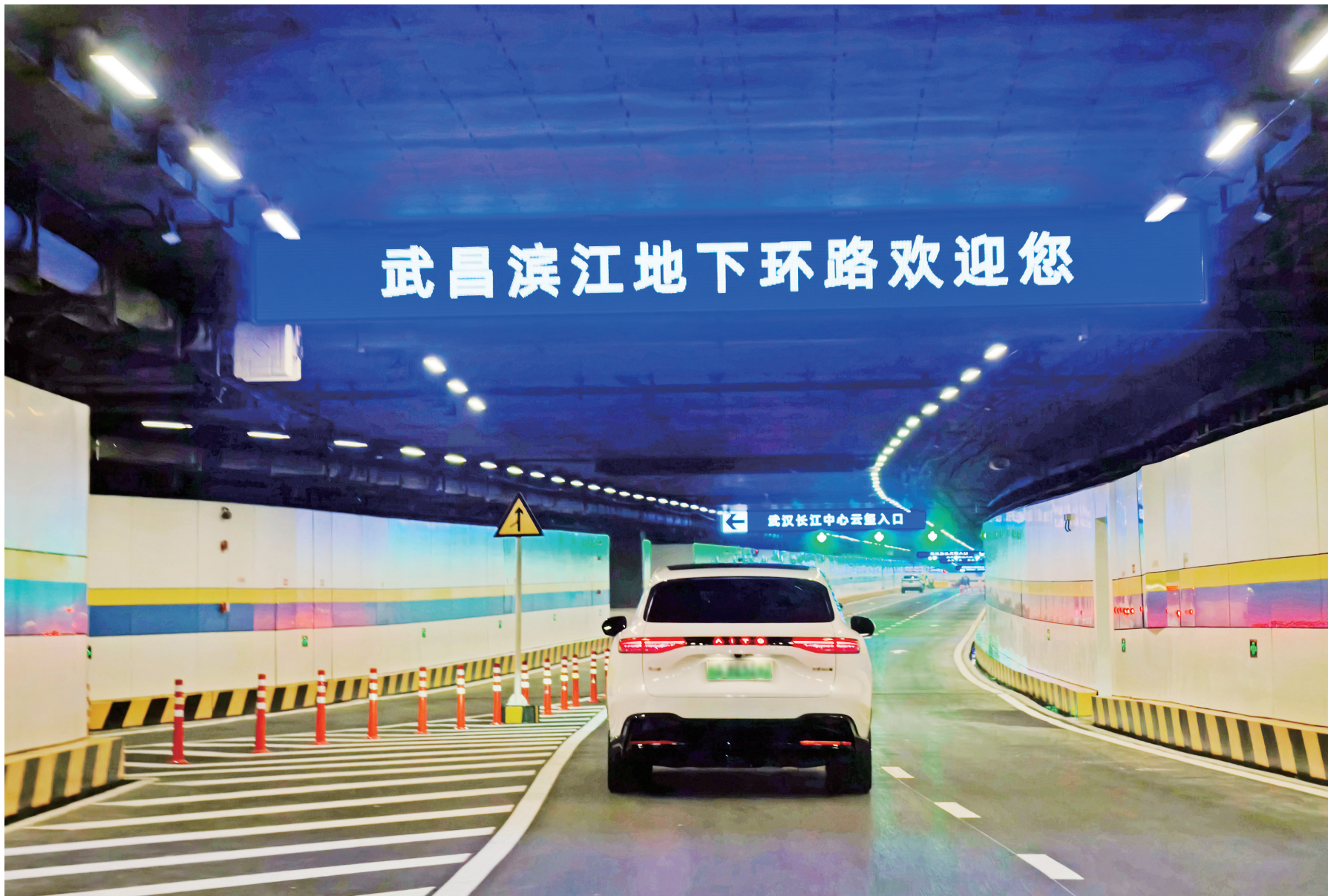
武昌滨江地下环路内景。
