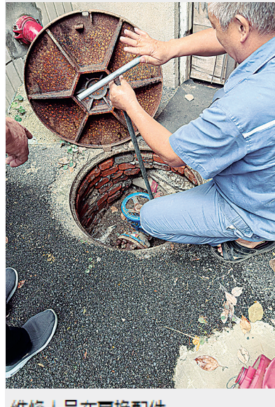
维修人员在更换配件。
