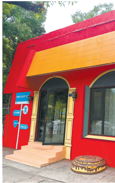
公园内的建筑穿上了新衣。
