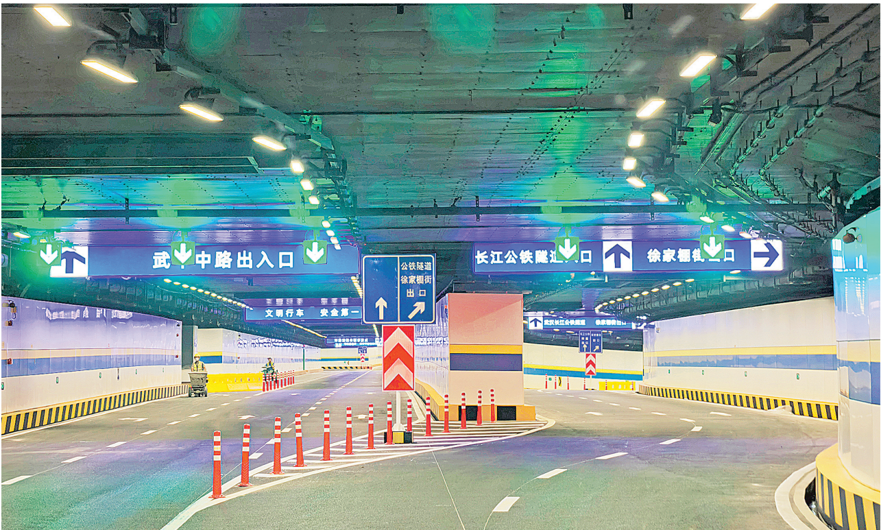
武昌滨江地下环路内景。
