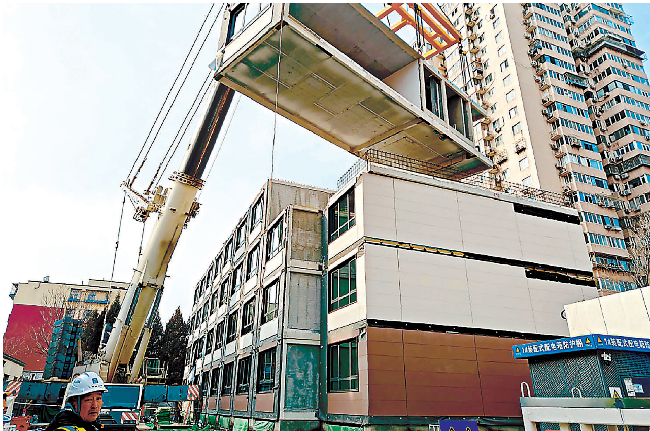
北京丰台区开阳里三区19号像“搭积木”一样建房子,很短时间就完成了4层居民楼的“原拆原建”。
