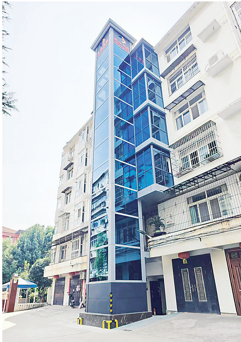
人社局南小区加装电梯完工。
