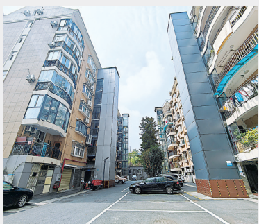
狮龙花苑多个单元已加装电梯。
