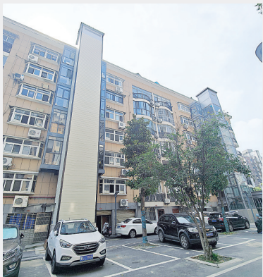
电梯完成安装。
