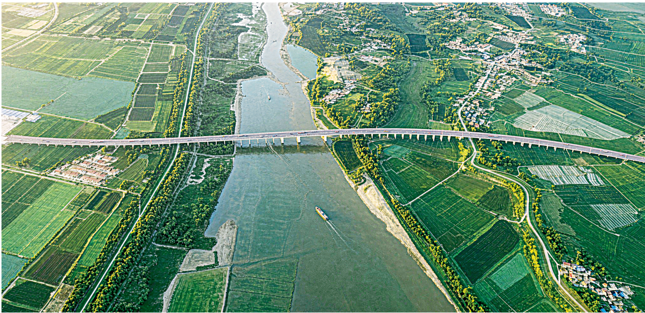
G347举水河大桥航拍。
