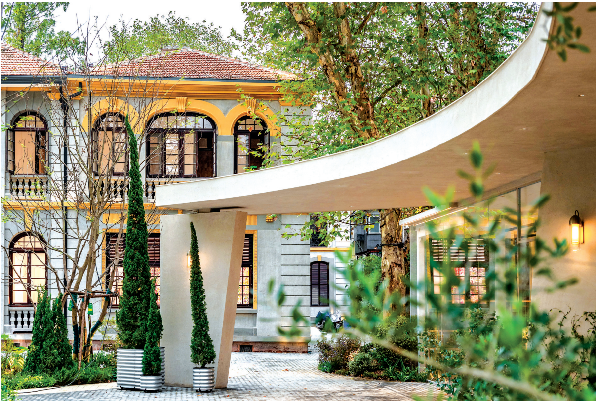
“洞庭81”院内,原法国领事馆旧址已修缮一新。
