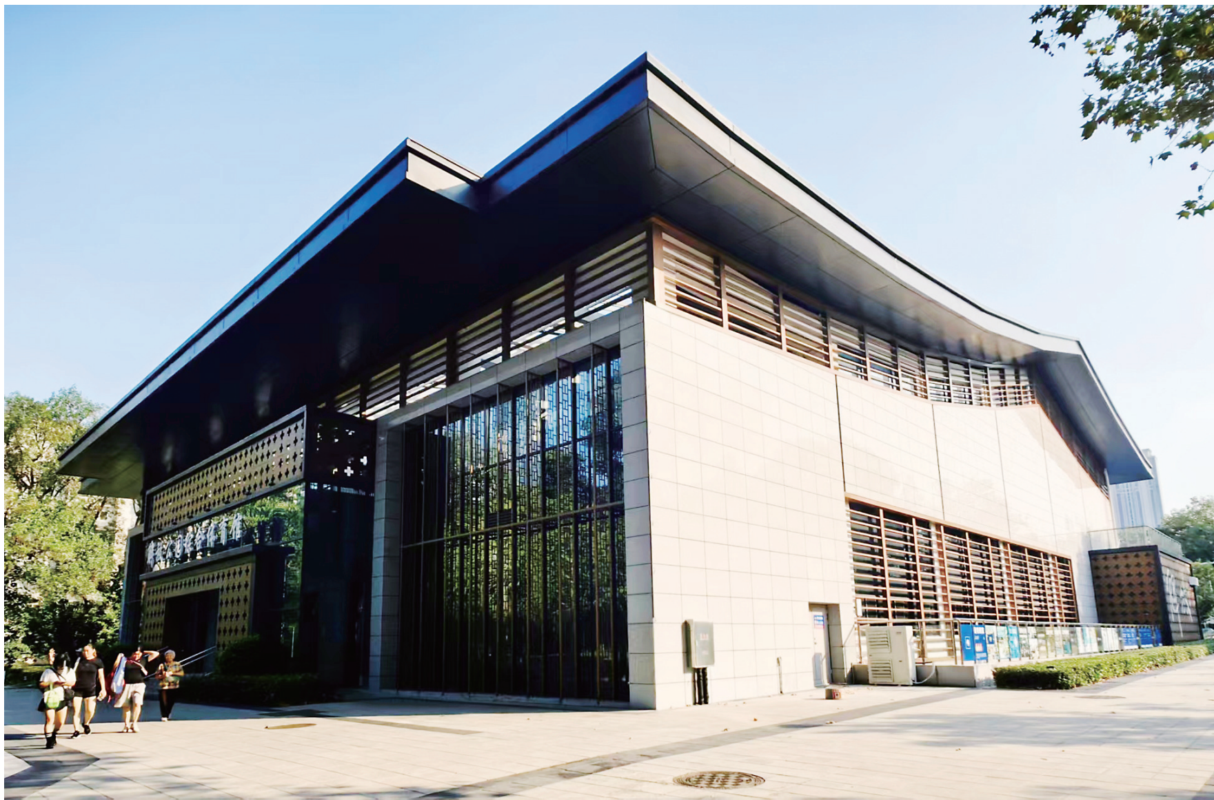
解放公园综合体育馆。
