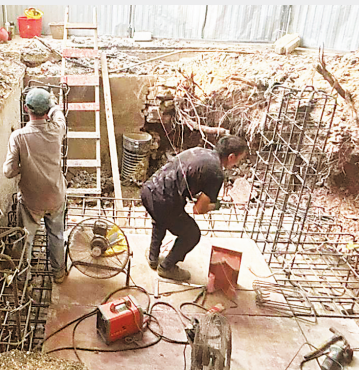
知音社区联系多方现场勘察电梯井施工。
