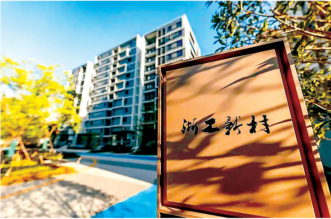
重建后的杭州浙工新村小区。
