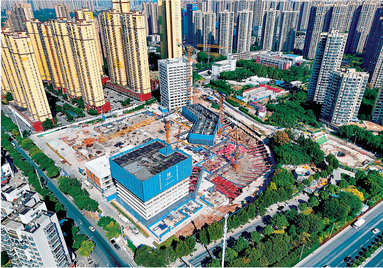
向阳村保障性住房项目正在建设中。
