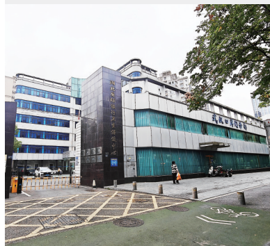
居民家门口有医院。
