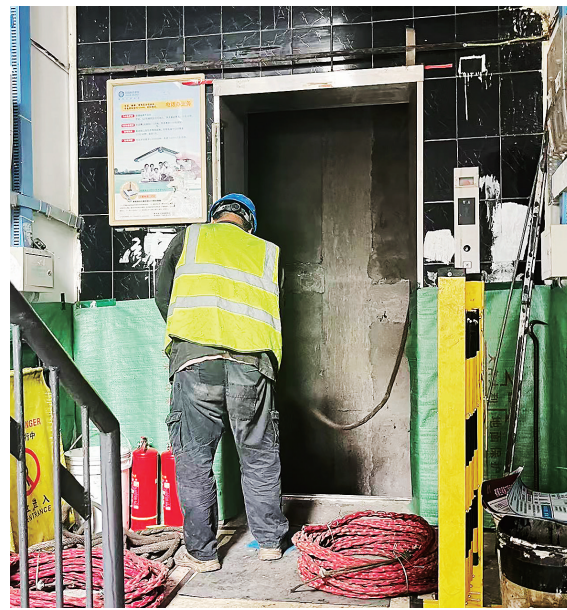
推进电梯更新改造,筑牢居民出行安全防线。
